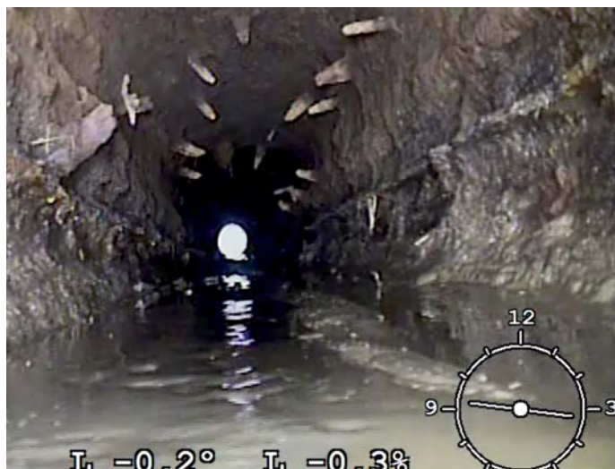
Kamerová prohlídka – potrubí před sanací
