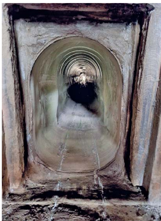
Potrubí po vytvrzení a celkové sanaci
