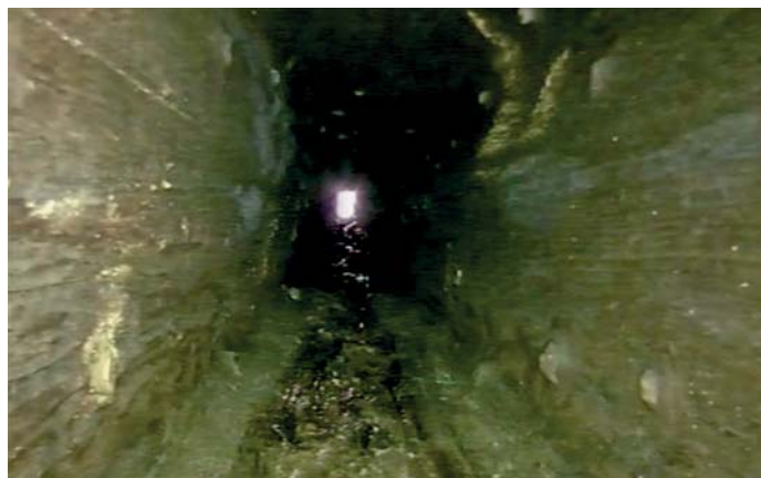
Potrubí před sanací po odfrézování suků a tlakovém čištění
