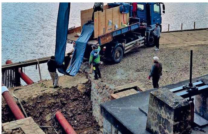
Zapravení napuštěného rukávce do potrubí
