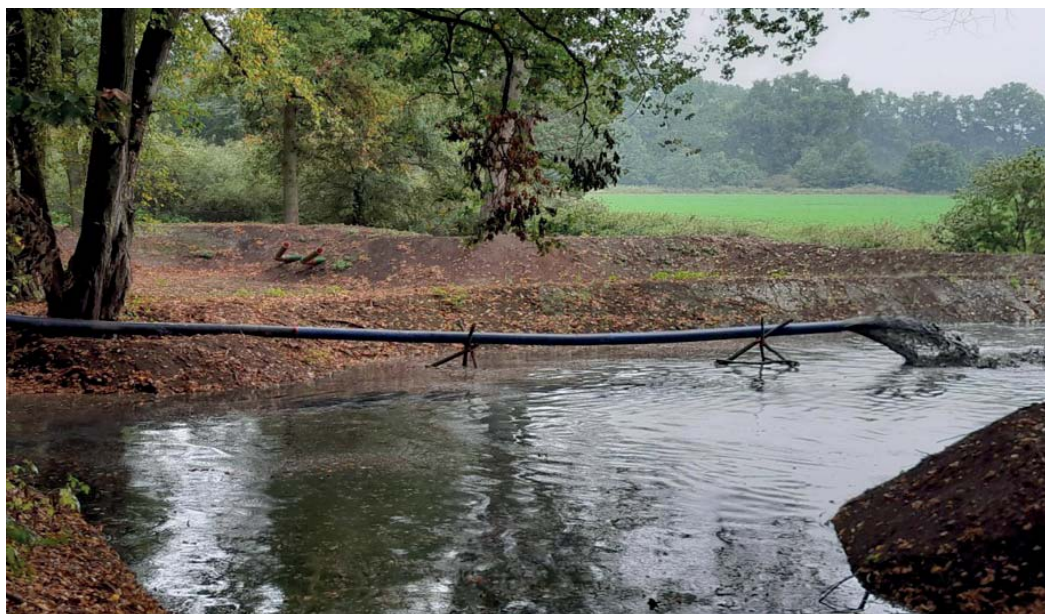
Plnění laguny sedimentem – Velký Tisý (zdroj: Rybářství Třeboň a.s.)
