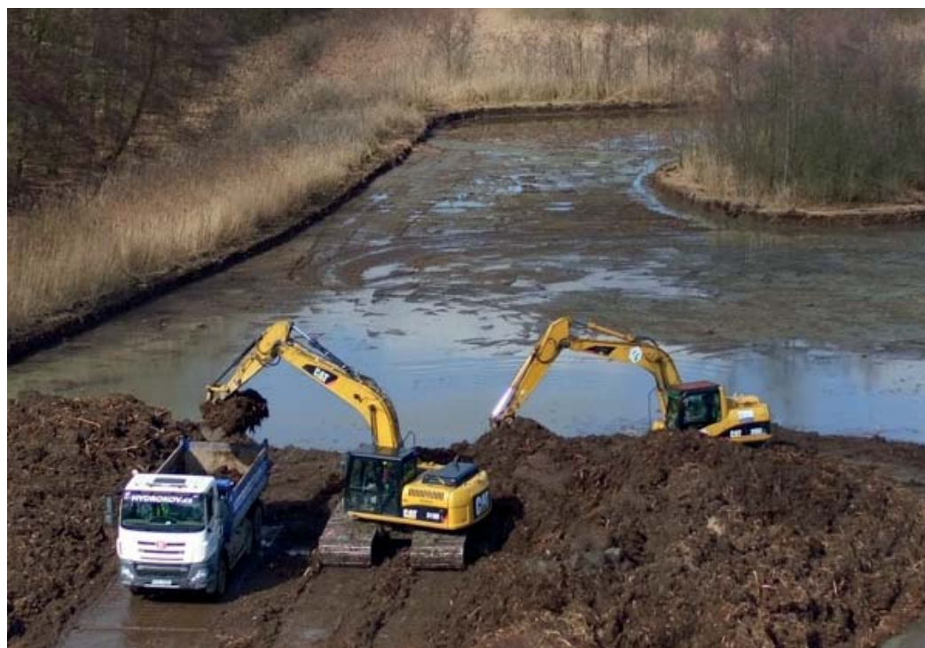
Celkové odbahňování nádrže (zdroj: www.hydrokov.cz)
