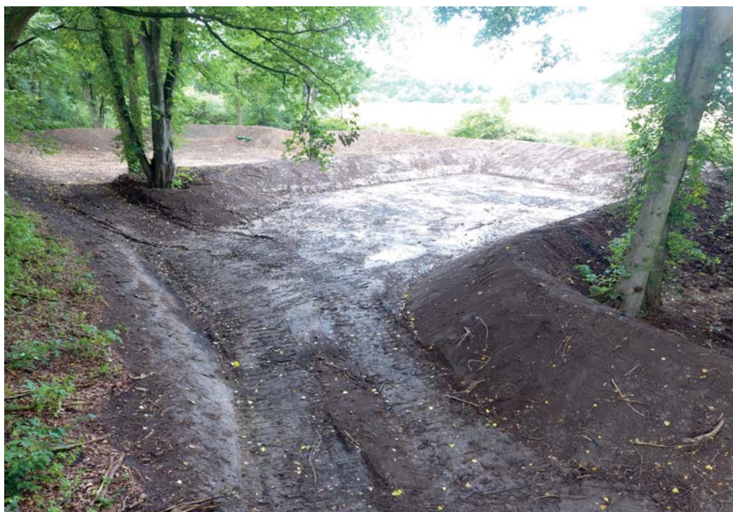
Laguna připravená na plnění sedimentem – Velký Tisý (zdroj: Rybářství Třeboň a.s.)
