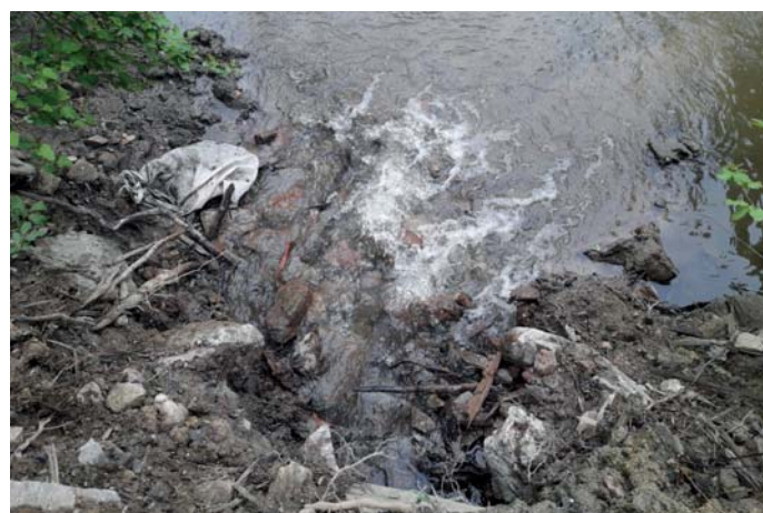
Obr. 1: Výtok vody unikající ze Zámeckého rybníka u zámku Červená Lhota.
