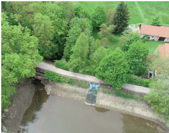
Obr. 2: Pohled na návodní stranu hráze Zámeckého rybníka u zámku Červená Lhota s aplikovaným provizorním řešením.
