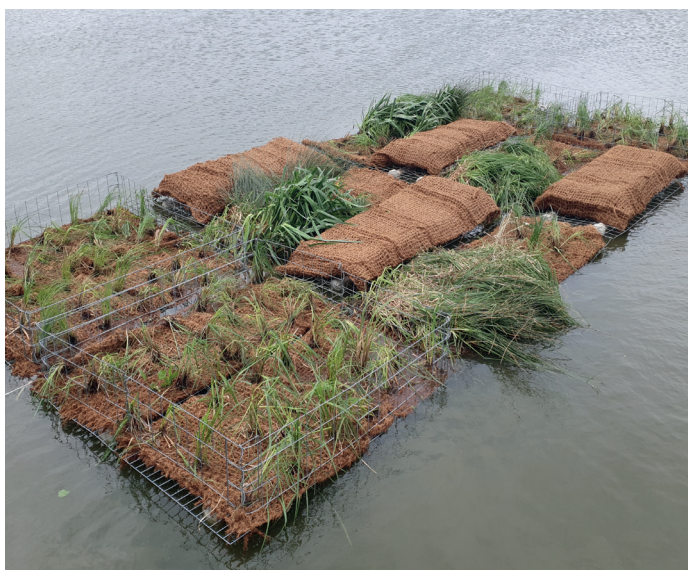
Obr. 1 – Rybník Kardaš, ostrov připravený k zakotvení (květen 2024), ochranné ohrádky dočasně chrání vegetaci před herbivorními ptáky, po roce budou odstraněny
