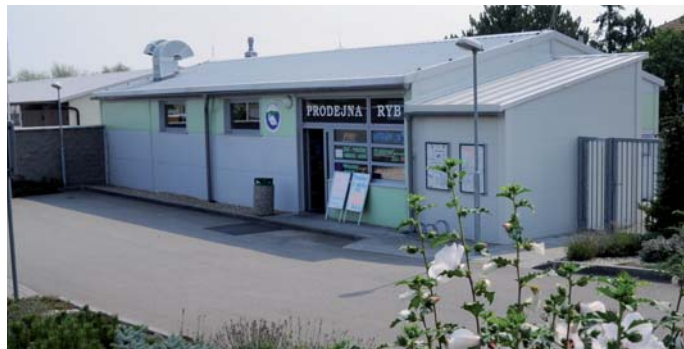
Pohled na prodejnu od příjezdové silnice.
