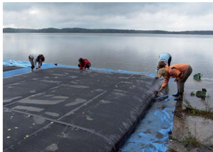
Obr. 2: Odběr vzorků vody vytékající z geotextilních vaků
