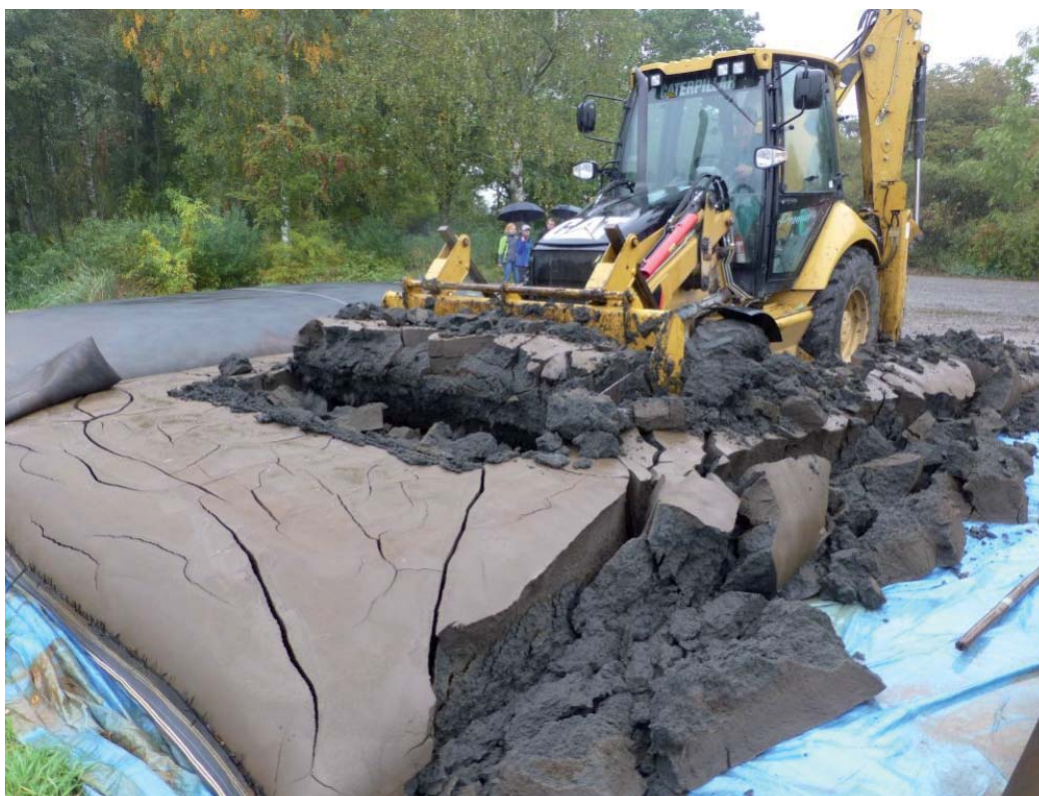
Obr. 4: Nakládání odvodněného sedimentu
