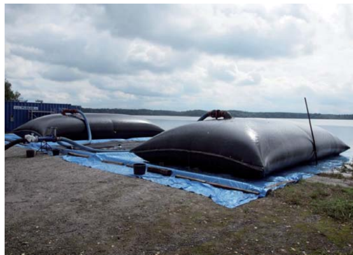
Obr. 1: Plnění geotextilních vaků
