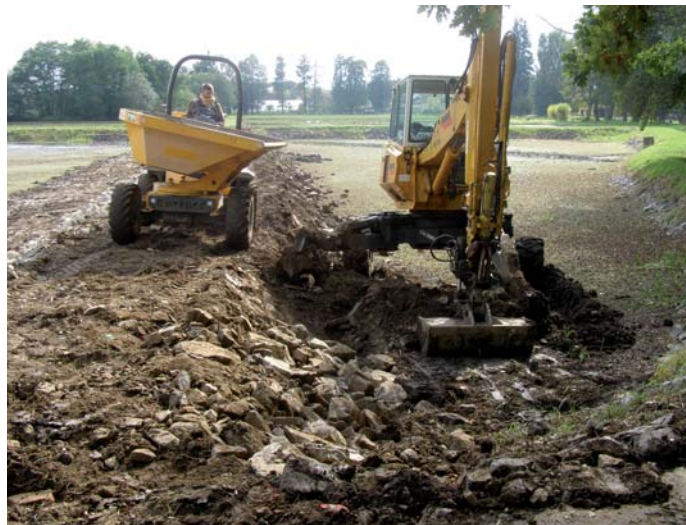
Oprava hrází na školním pokusnictví.
