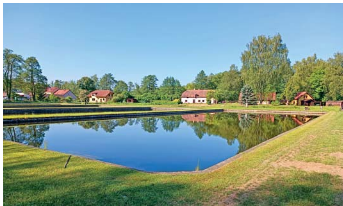
Opravené Pokusné rybníčky 1–5
